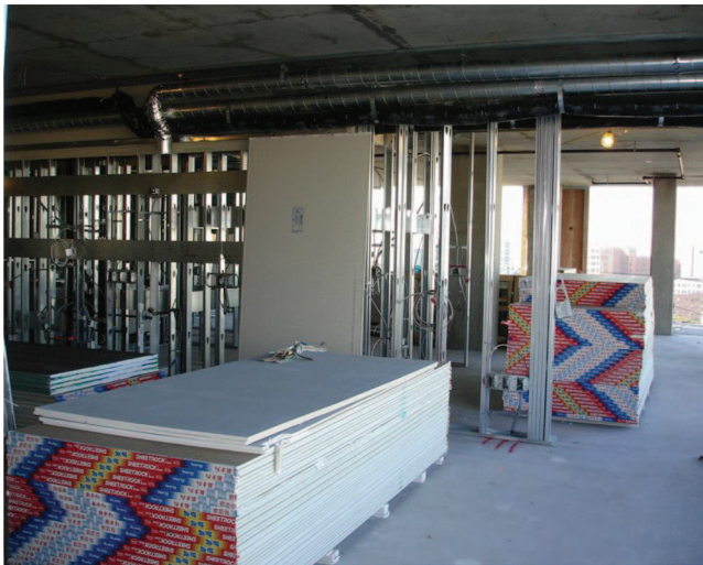
Fig. 6-3. Preloading of Drywall
