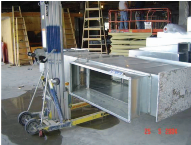
Fig. 6-18. Duct Subassembly
